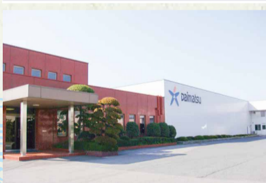
ダイマツ本社外観
